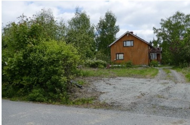
Kuva 1. Näkymä tontille Poratieltä. Kuvassa näkyy tontilla sijainnut 50-luvun asuinrakennus, joka purettiin vuoden 2023 aikana. Valokuva: Annamaria Puumala 2023.
